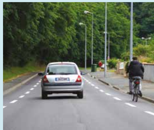
La chaussée à voie centrale banalisée rue Georges Stephenson.
